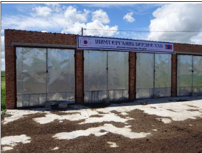
協会と JICA の支援による堆肥化施設
