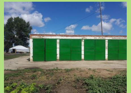
建設当時のジャルガラント町堆肥化施設 発酵槽
