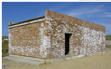
工事中の堆肥化施設
