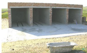
工事中の堆肥化施設投入口
